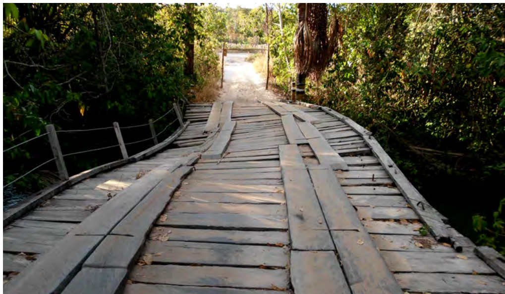
Foto 33 Ponte sobre o Rio da Estiva ou Galheirão, em São Desidério
