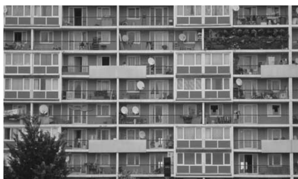
Imagem 8 Conjunto habitacional La Cité des Quatre-Mille, La Courneuve, França
