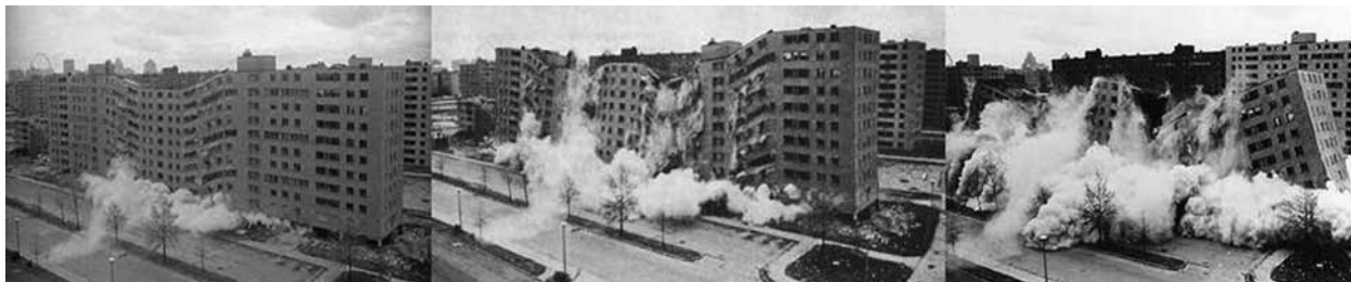
Imagem 7 Demolição do conjunto habitacional Pruitt-Igoe, em Saint Louis, EUA (1972)
